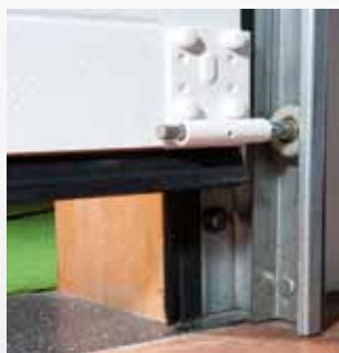
Particolare guarnizioni di tenuta.
