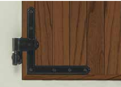
Dettaglio ferramenta storica su pannello
